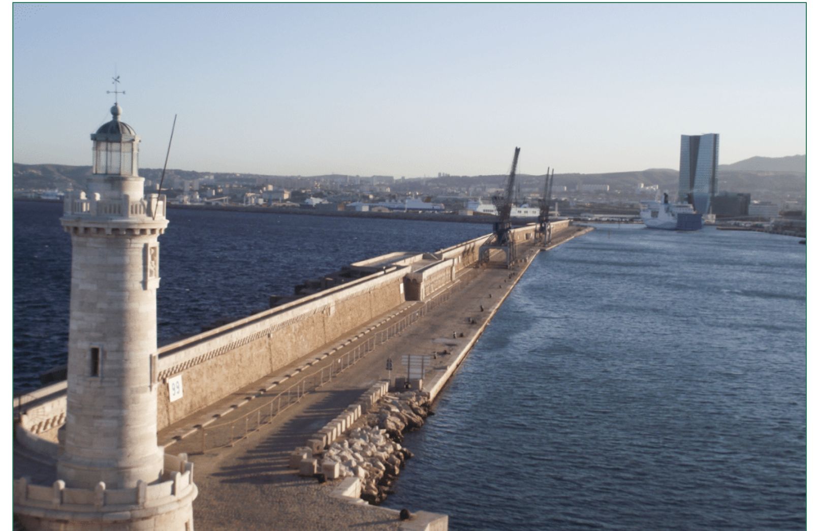
Digue du large de Marseille @Fotocommunity
